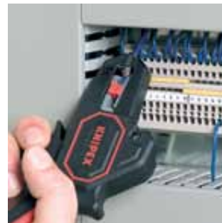
Ściąganie izolacji w trudno dostępnych miejscach
